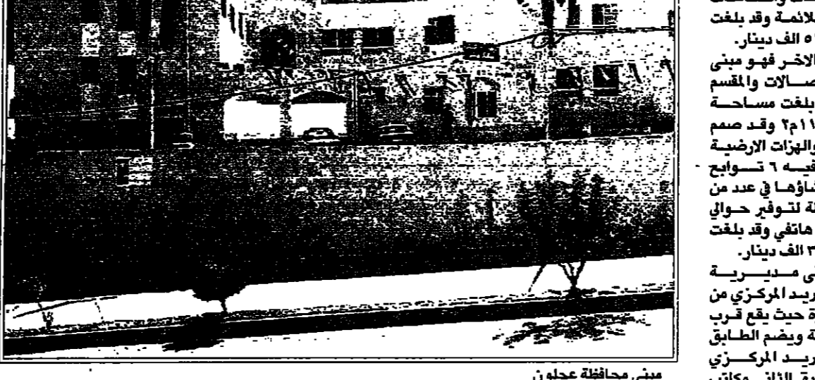
مبنى محافظة عجلون
